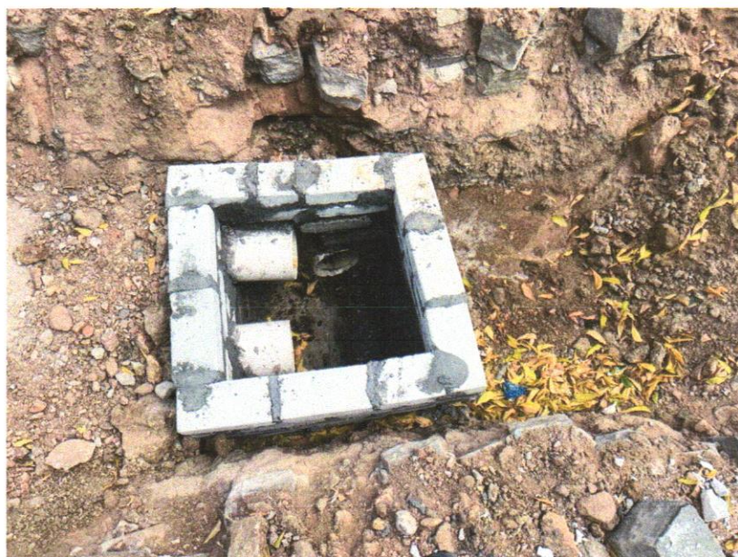
Foto 06 – ALVENARIA DE BLOCOS DE CONCRETO ESTRUTURAL 14X19X39 CM, (ESPESSURA 14 CM) FBK = 14,0 MPA, PARA PAREDES COM ÁREA LÍQUIDA MENOR QUE 6M 2 , SEM VÃOS, UTILIZANDO PALHETA. AF_12/2014
