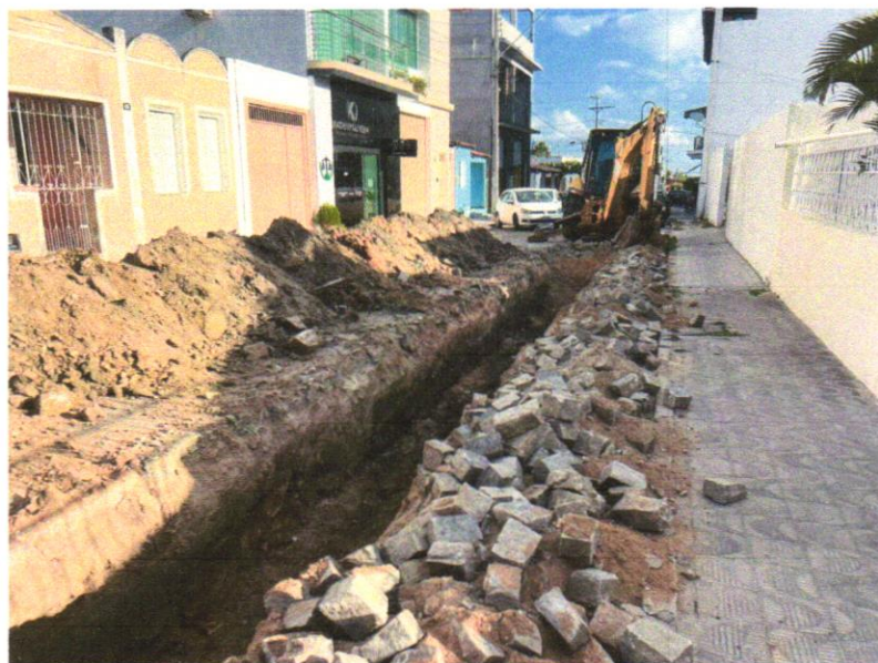
Foto 02 – ESCAVAÇÃO DE VALA
