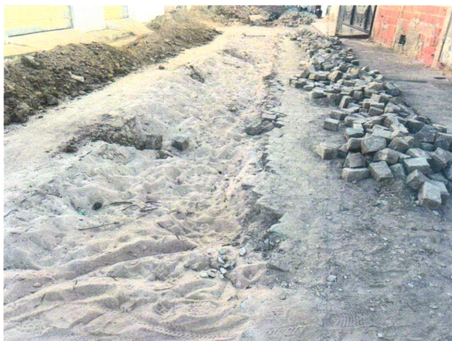
Foto 04 - ATERRO MANUAL COM SOLO ARGILO-ARENOSO IMPORTADO E COMPACTAÇÃO MECANIZADA EM CAMADAS DE 0,20 M NO MÁXIMO
