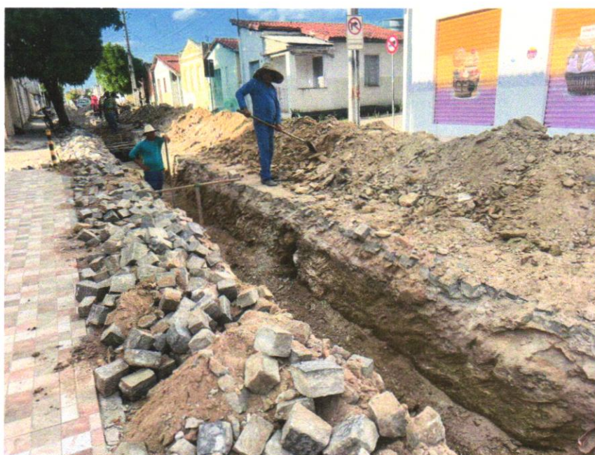
Foto 03 - ESCAVAÇÃO DE VALA
